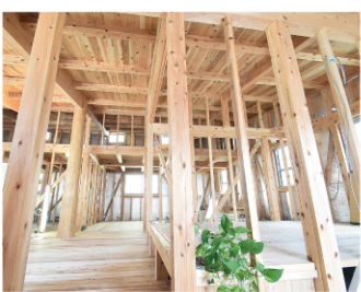
防菌・防カビ作用があるという音響熟成 ® 木材を使った家の骨組み
